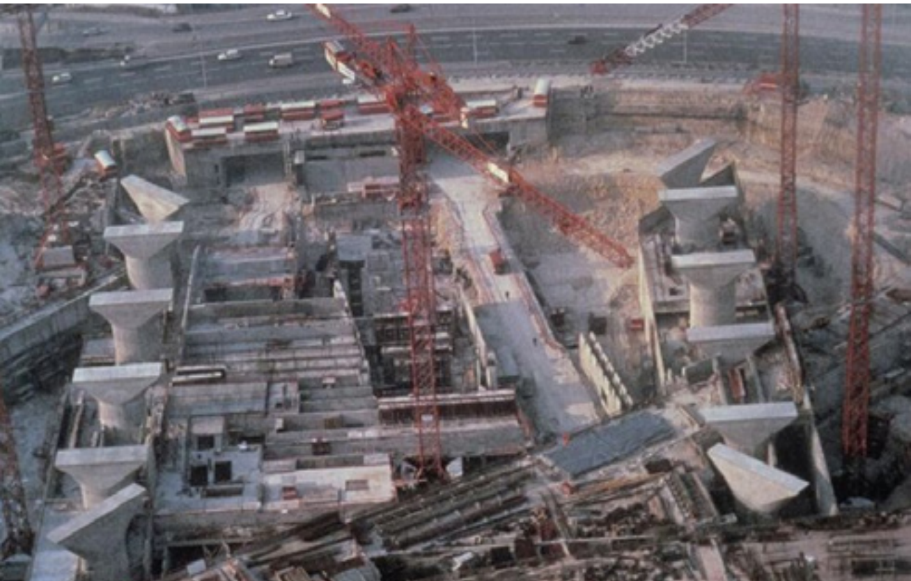
les fondations de l'arche de la Défense durant le chantier. Crédits : Le Parisien
